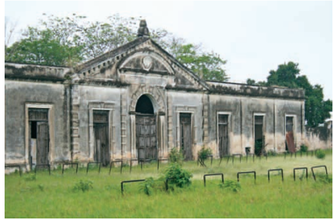
The drying area, Yaxcopoil Hacienda.
